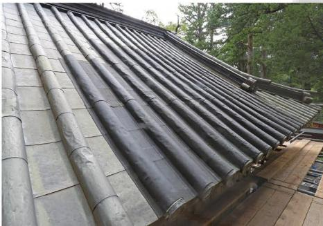
西背面 屋根銅板 破損箇所被覆状況
