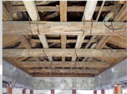
文政2年(1819)の構造補強(5本の梁と2本の直交する補強木材を帯金物で緊結し一体化)
