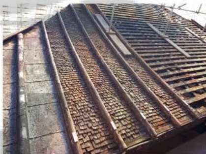
屋根のトタン(左)・栩葺(中)・小舞野地(右)
