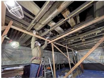
格天井の格線解体中
