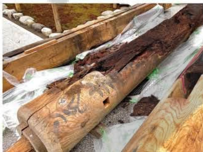
心柱(写真右)・控柱(写真左) 何れも虫害破損と雨水浸入による木部腐朽を確認
