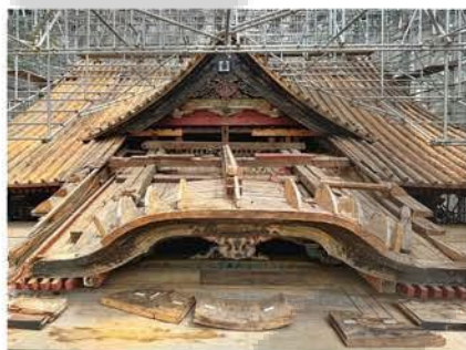
半解体修理中（向拝）
