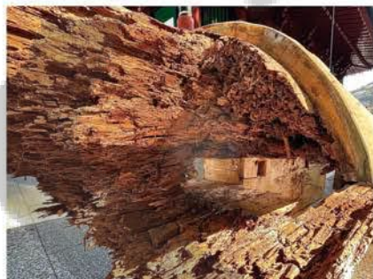
心柱(写真右)・控柱(写真左) 何れも虫害破損と雨水浸入による木部腐朽を確認
