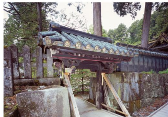
倒壊防止用応急処置
