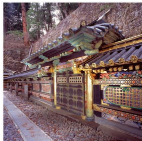
背面唐門 (南東からの見通し)
